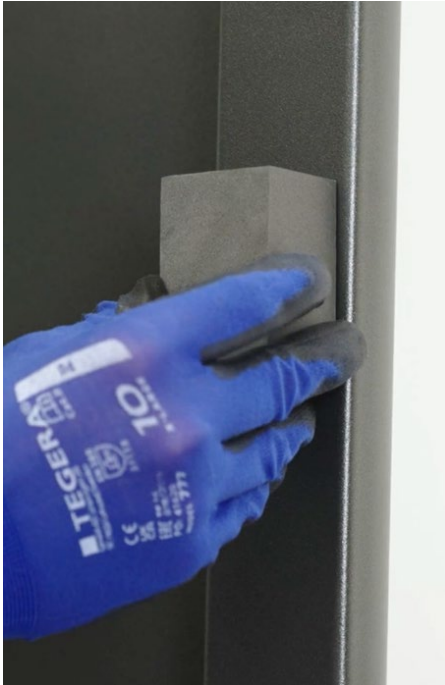
Afbeelding 38: Afstandhouder positioneren
