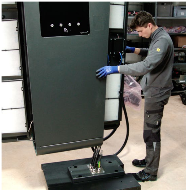
Afbeelding 48: HYC400 op sokkel plaatsen en bevestigen
