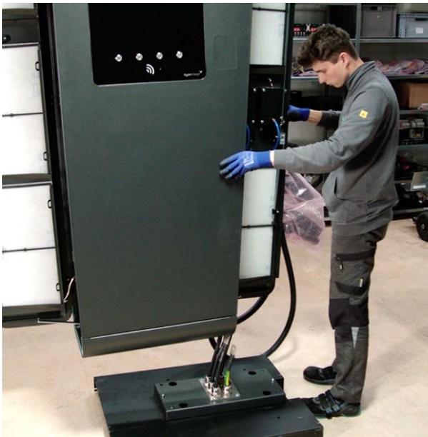
Afbeelding 54: De HYC200 op de basis plaatsen en bevestigen
