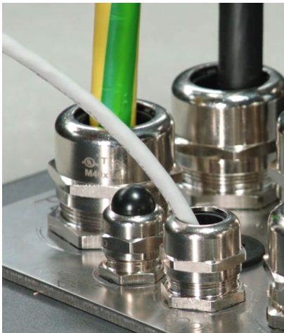
Afbeelding 53: Draai de kabelwartels vast
